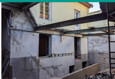
...En créant des espaces extérieurs en toiture
